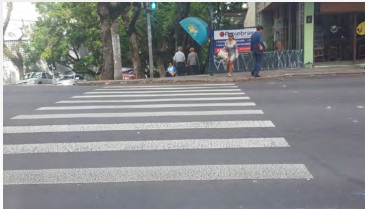
Figura 3: Falta de rampa de acesso- Av. Independência. Fonte: Dados de pesquisa, 2017.
