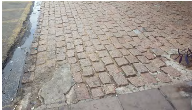
Figura 2: Desnível do calçamento. Fonte: Dados de pesquisa, 2017.
